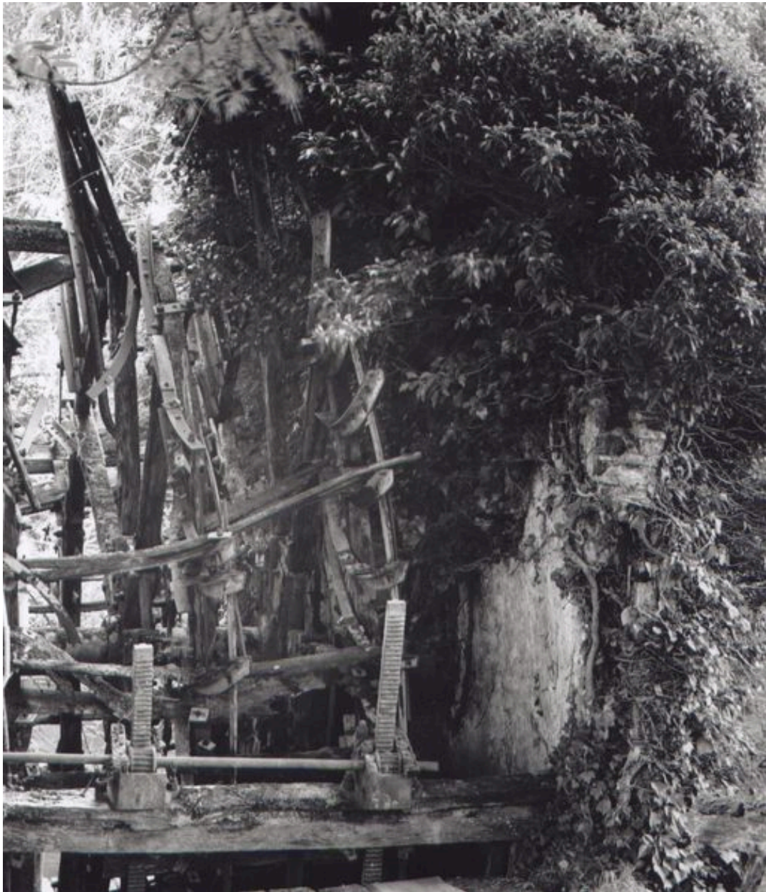
Détail des vestiges de l'armature métallique de la roue hydraulique.
