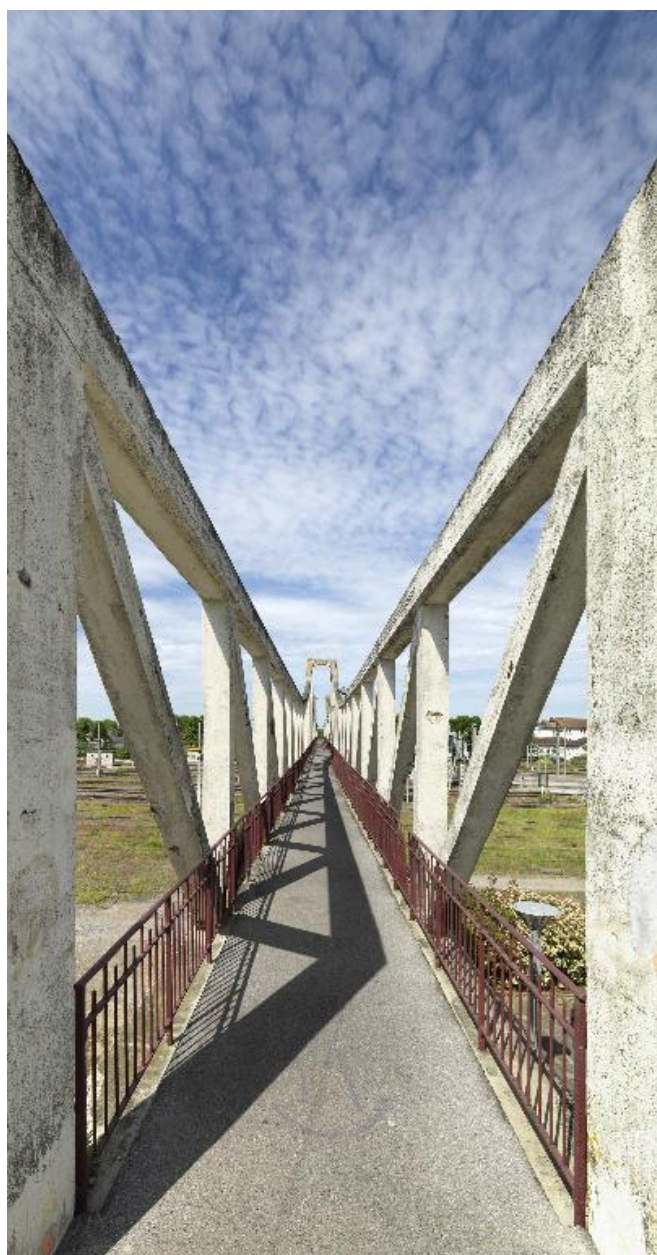
Vue générale depuis la passerelle.
