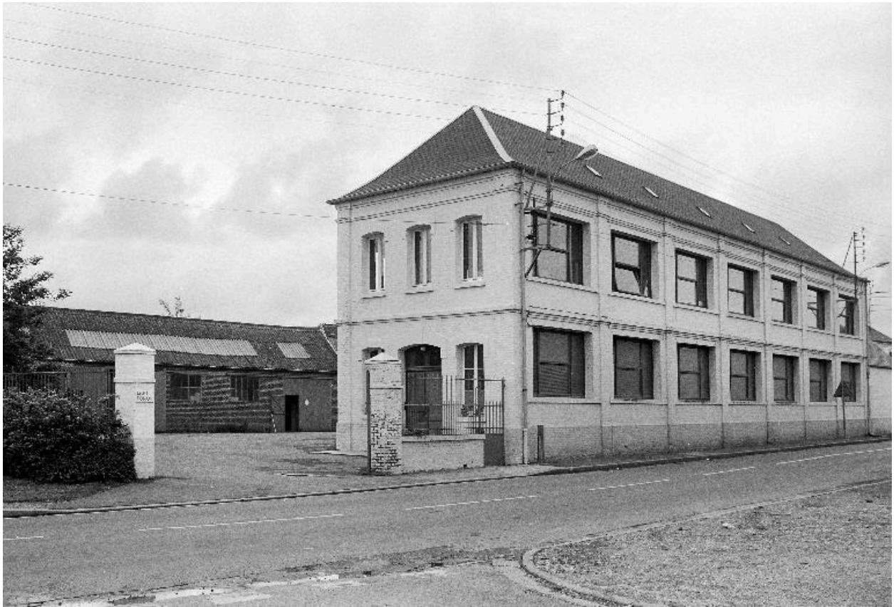
Atelier de fabrication (ancienne usine de serrurerie), flanc nord, en 1990.
