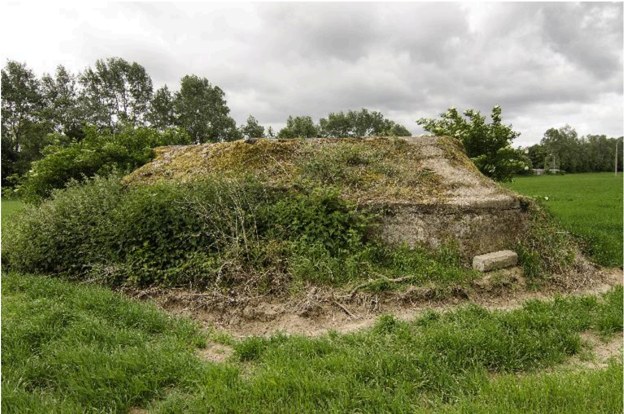
Vue de trois-quarts vers le sud.
