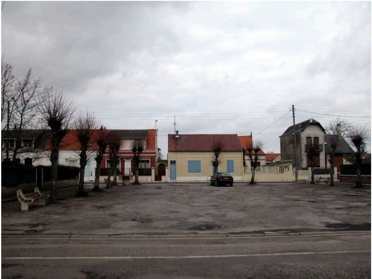
La place de Verdun et les maisons de la rue du 11 Novembre.
