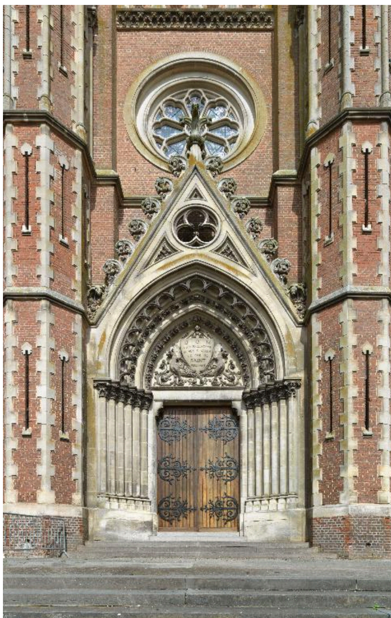
Détail du portail occidental
