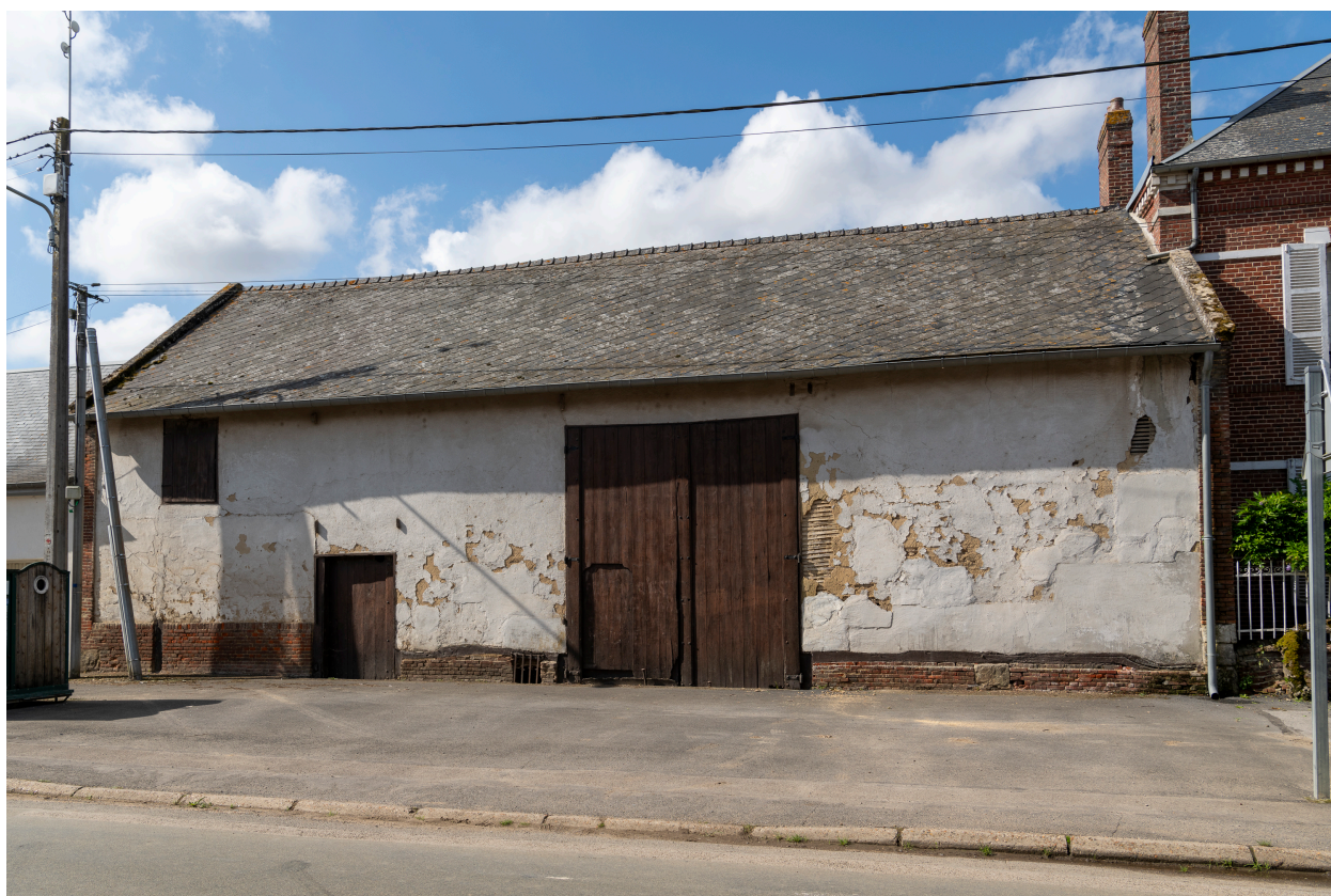
Grange d'une ferme à cour, n°49 de la Chaussée Brunehaut, vue depuis l'est.
