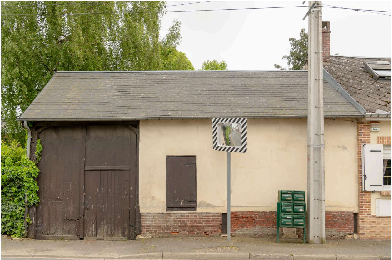
Ancienne grange avec porte à engranger, n°2 rue de Troussures (alignée sur la rue de Provinlieu), vue prise depuis l'ouest.
