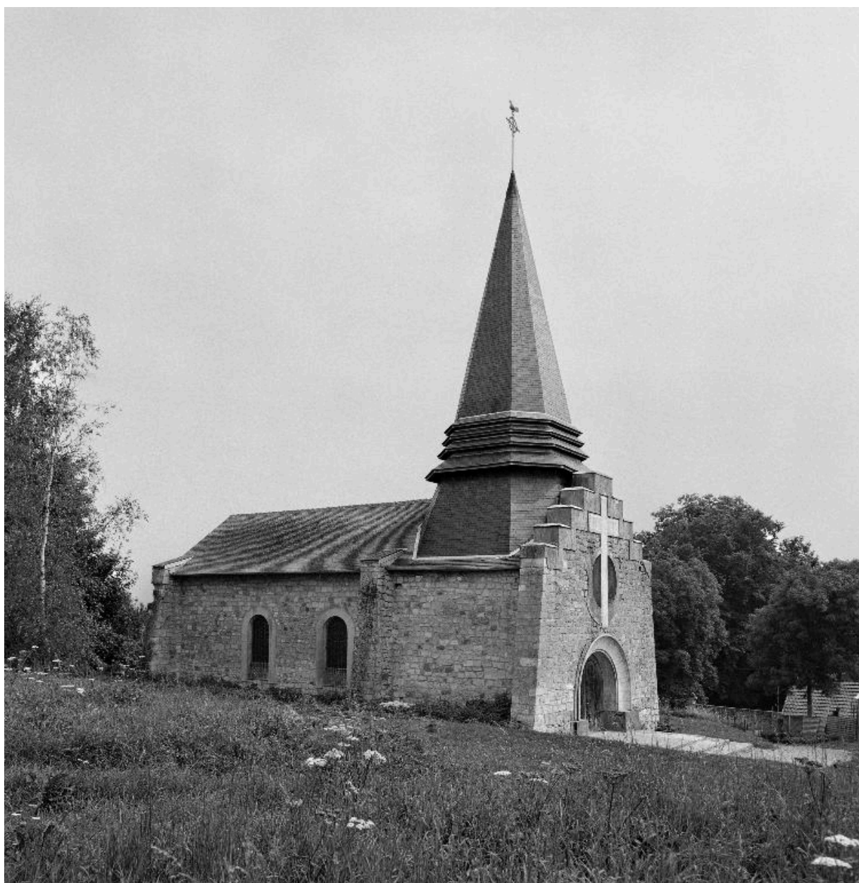
Vue de l'élévation nord-ouest.
