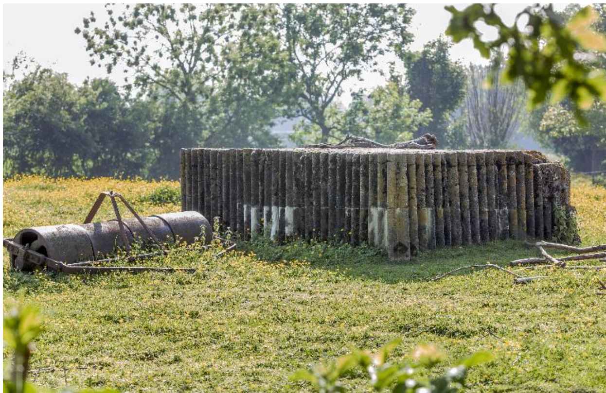
Vue arrière de l'édicule, vers le sud-ouest
