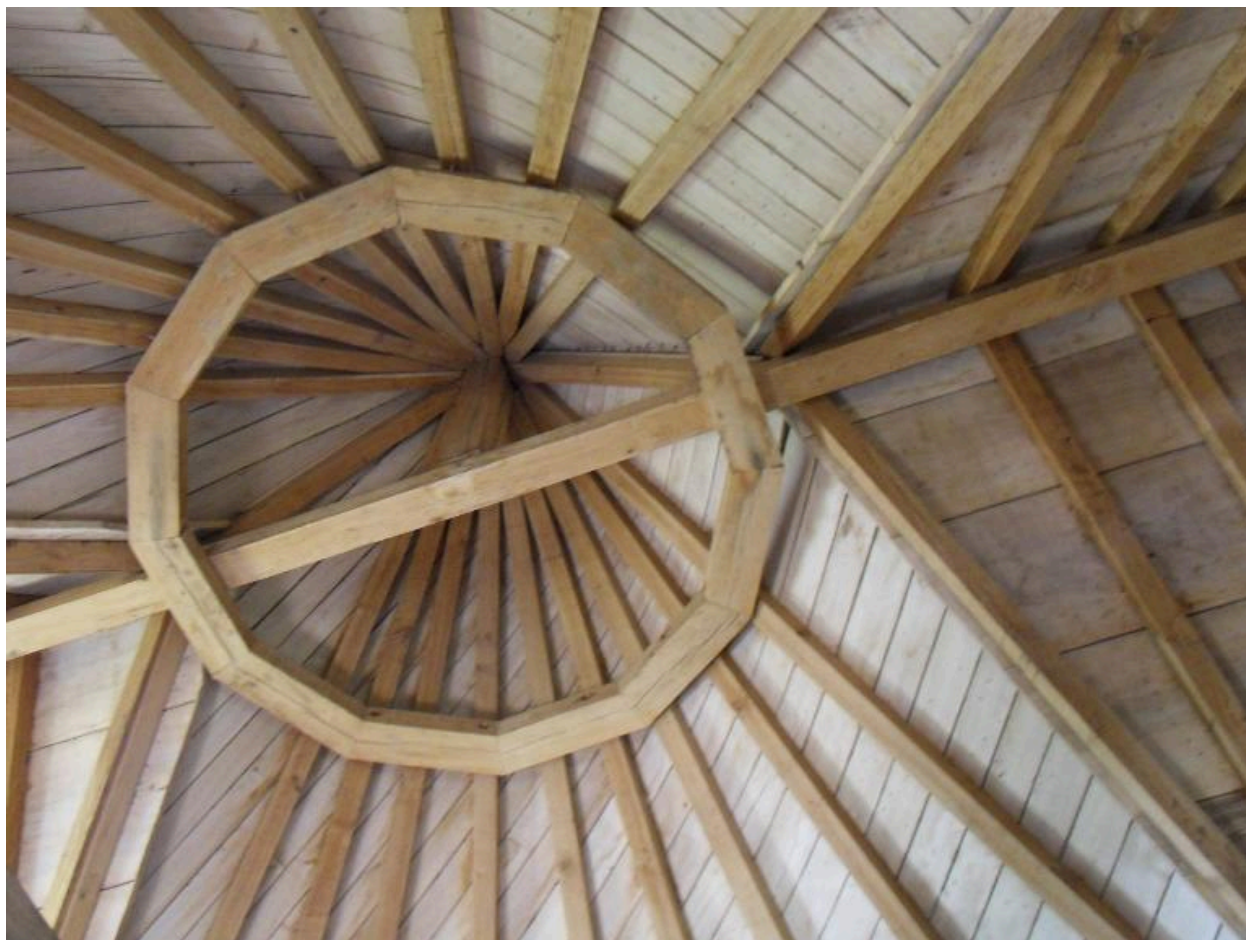
Vue de la charpente.
