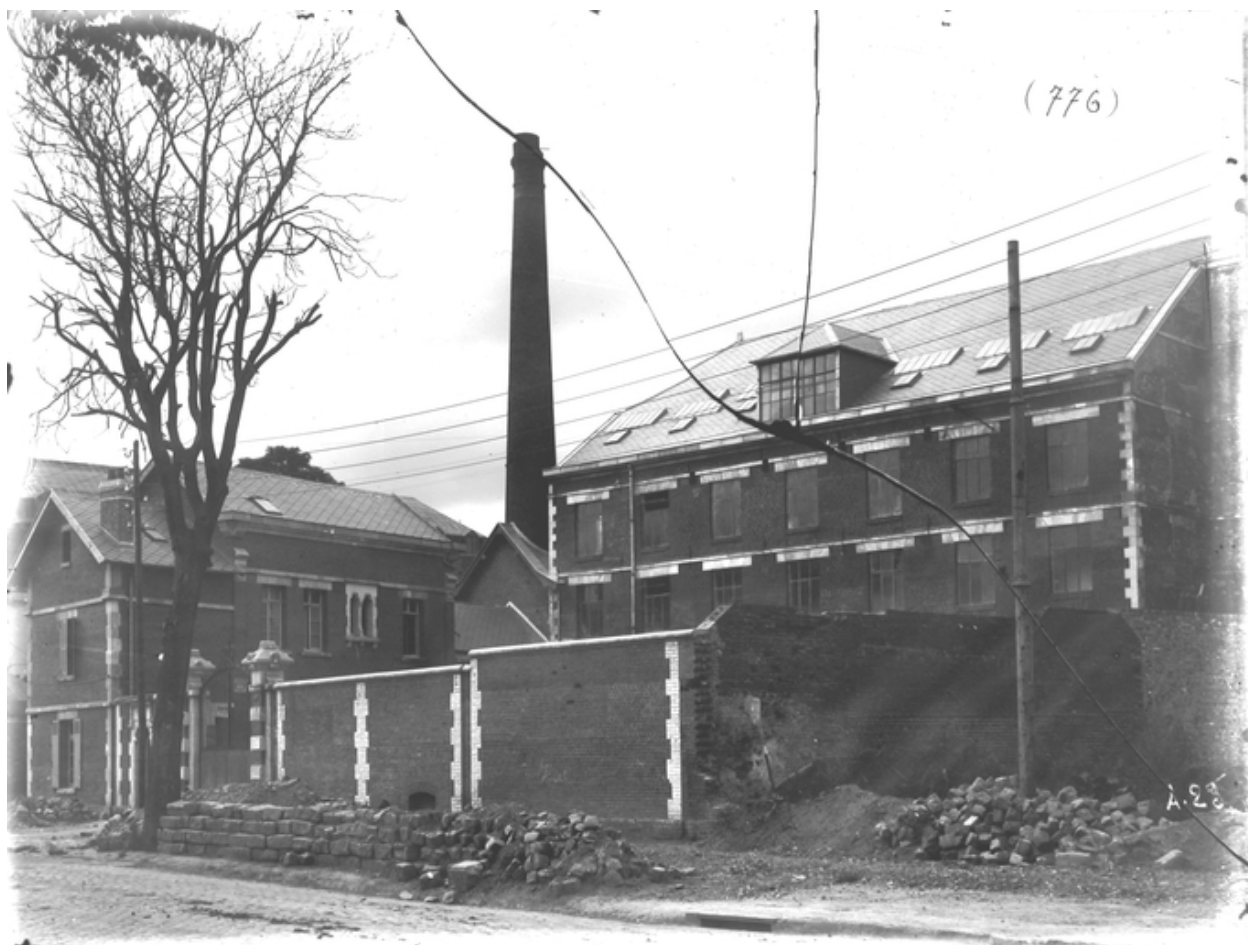
L'usine restaurée, vers 1919-1920 (AD Aisne).
