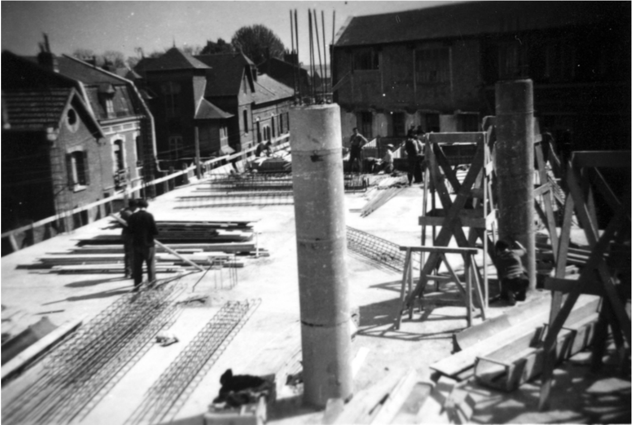
Chantier de construction des ateliers, 1948 (IFA).
