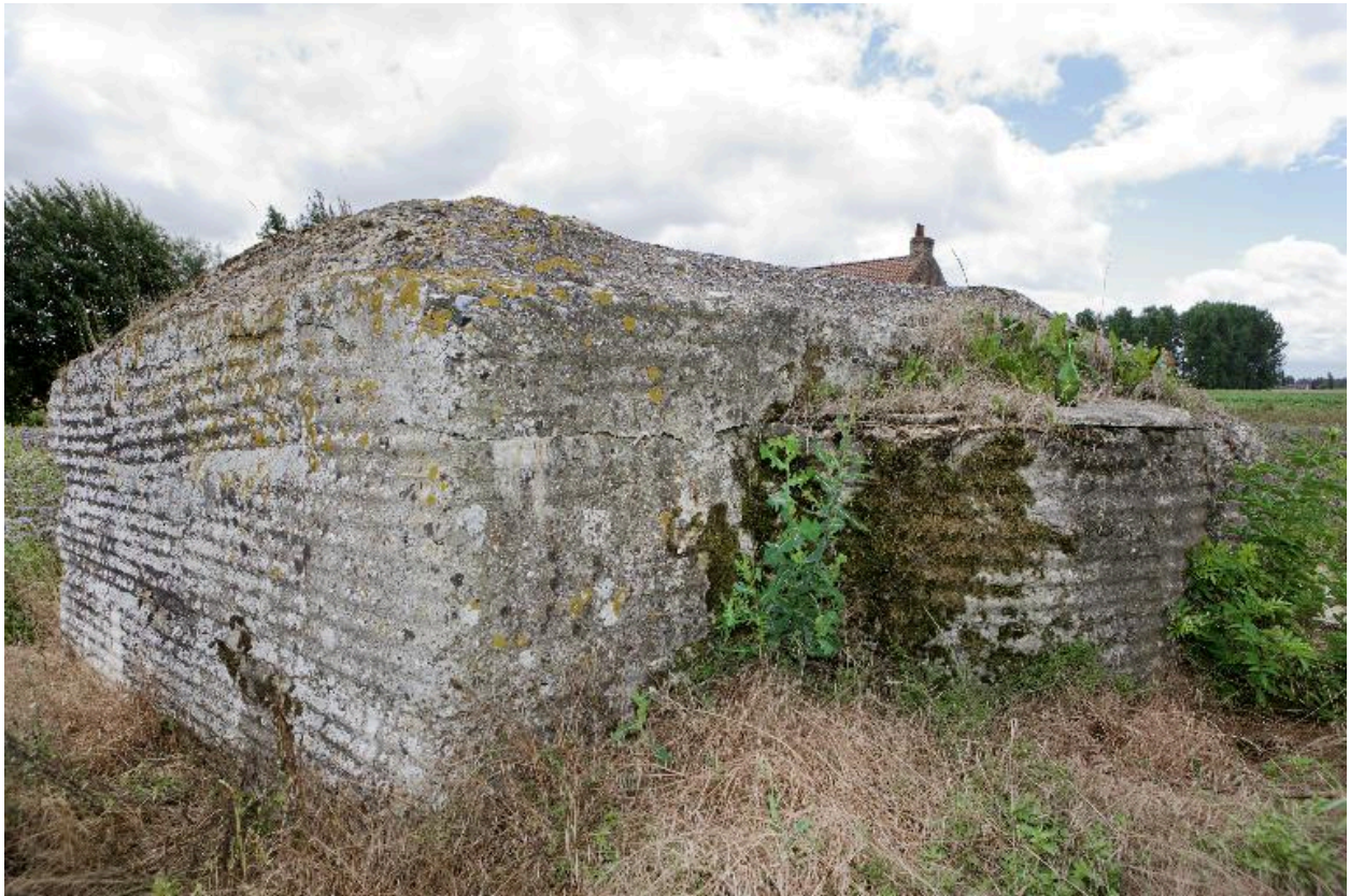
Vue de trois-quarts vers le sud
