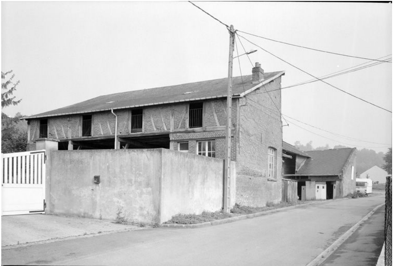
Ancien atelier de fabrication. Vue générale.
