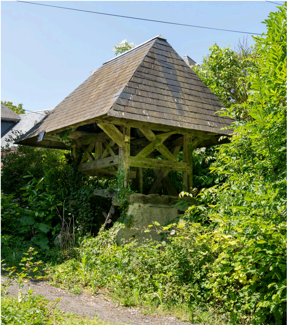
Puits, vue prise depuis le sud-est.
