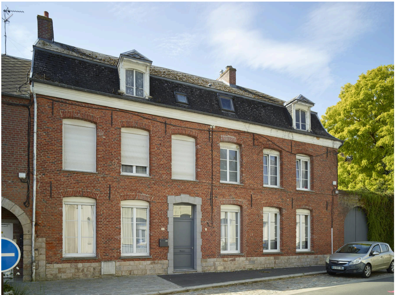
Maison de maître avec porte cochère - 19, rue Nouvelle-Zélande.
