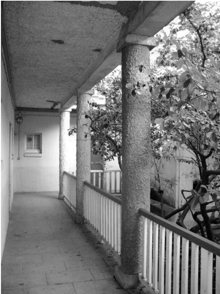
Bâtiment 520 : Détail de la coursive du rez-de-chaussée.
