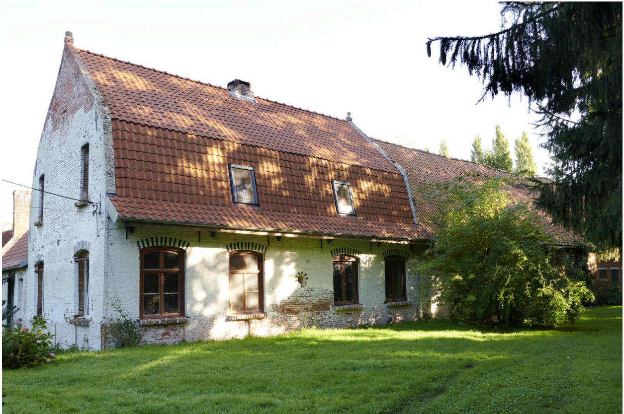
Façade sud et pignon ouest.
