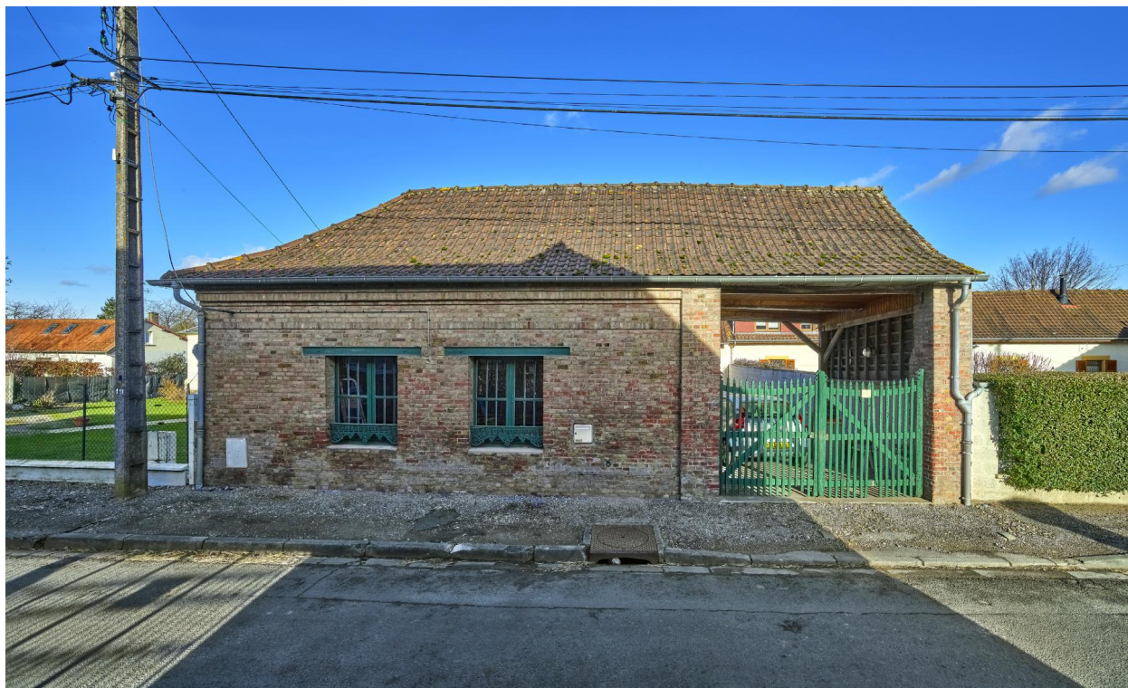
Vue de l'atelier sur rue, de face, depuis le sud.
