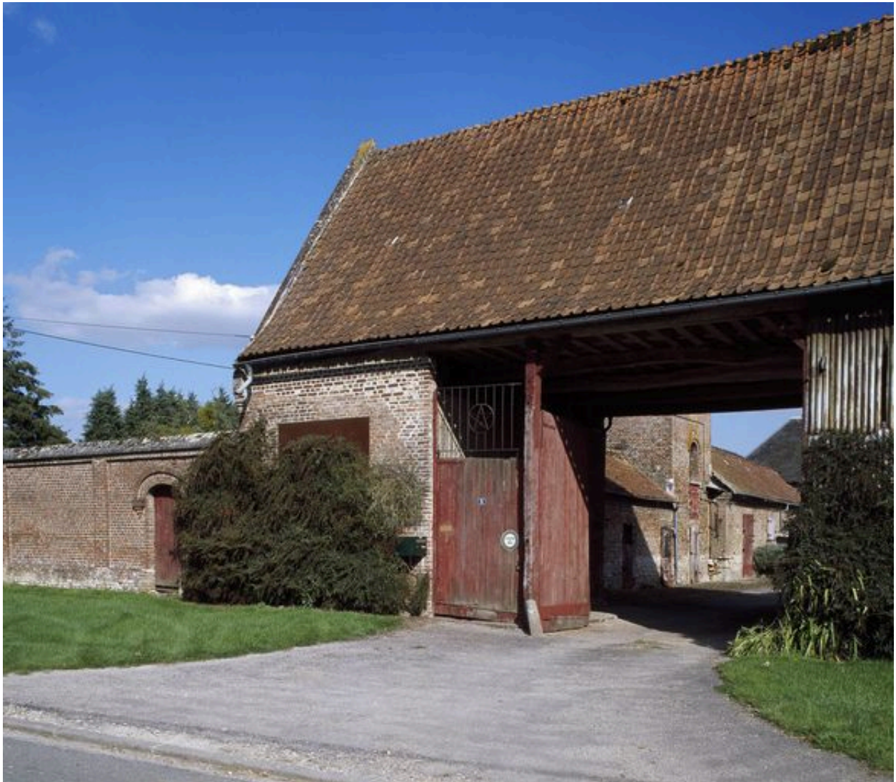
Porte et passage charretiers.
