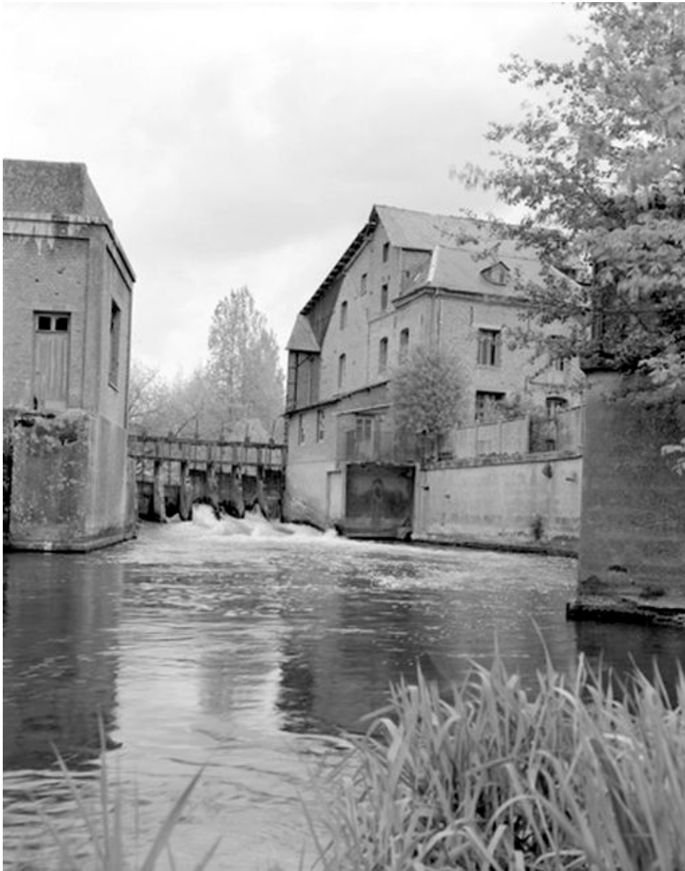
Bâtiment d'eau, vannages et moulin à farine, vue partielle.
