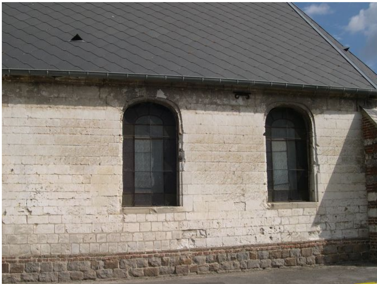
Fenêtres du choeur (mur sud).
