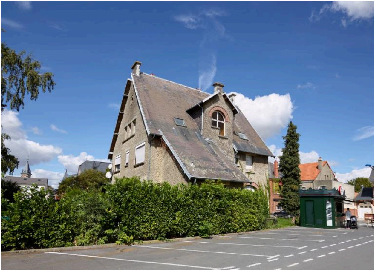
Façade latérale gauche depuis l'ancienne cour de la ferme (actuel parking de supermarché).
