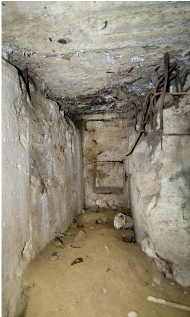
La coursière de tir en enfilade. Dans le fond, la niche à munitions
