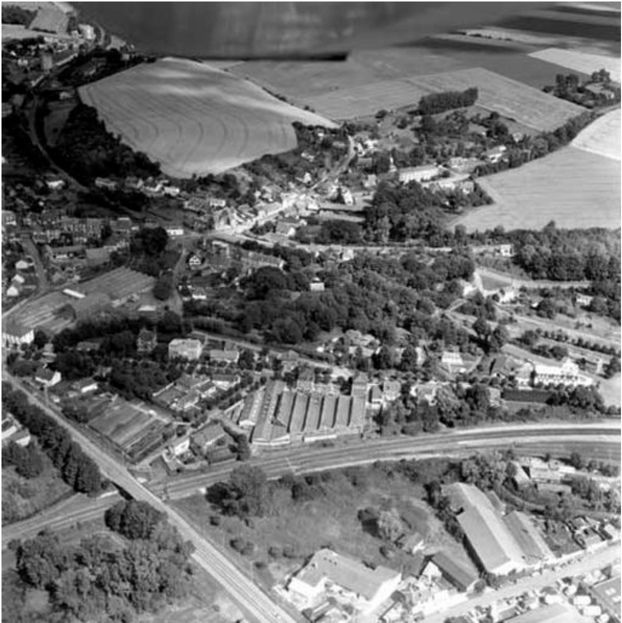
Vue aérienne de l'usine avec vue partielle de la ville.
