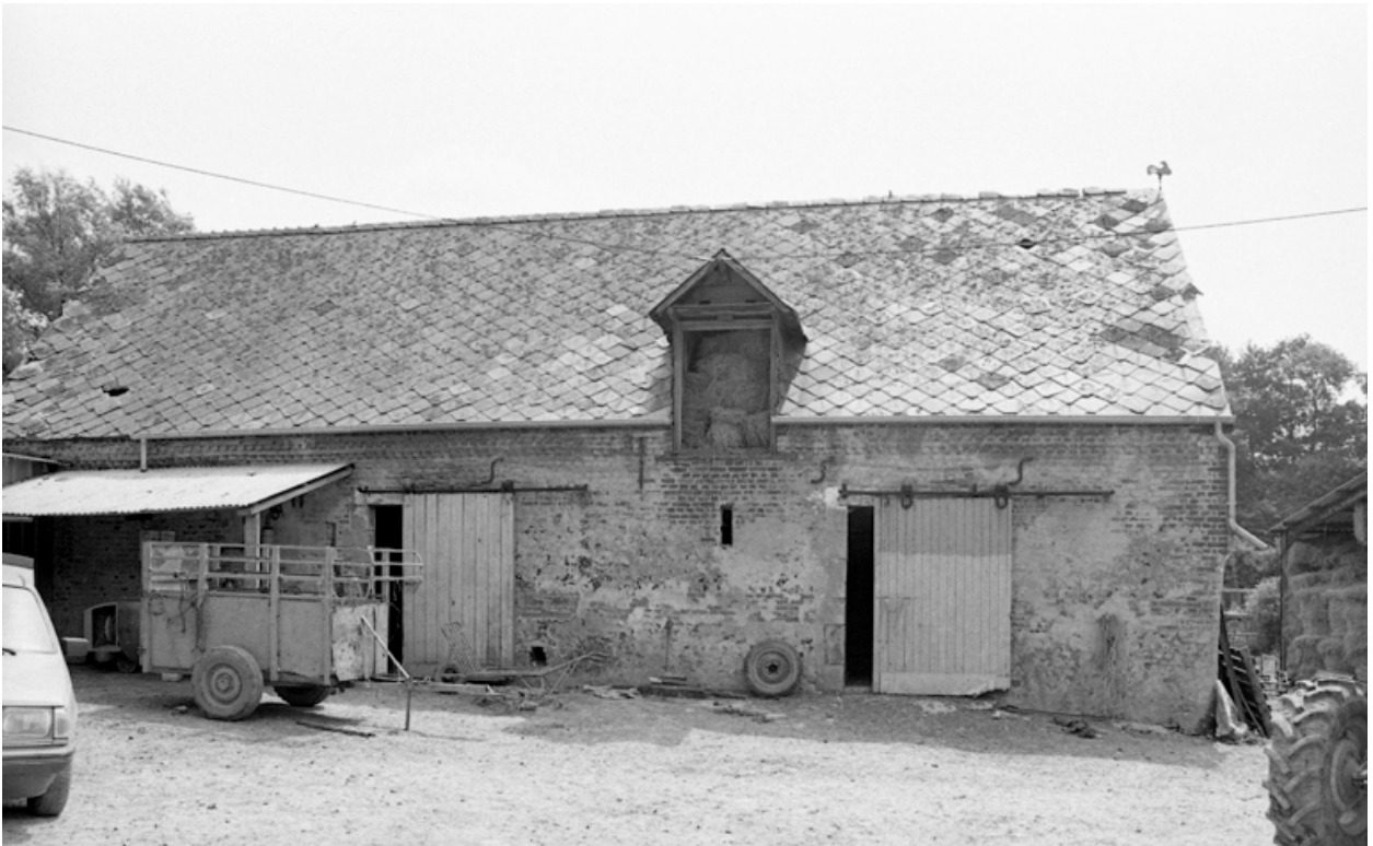
Elévation sur cour de l'étable sud-est.
