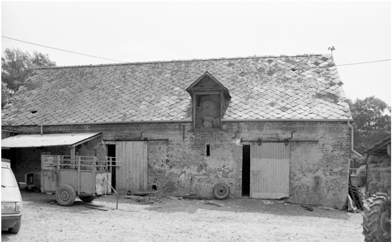
Elévation sur cour de l'étable sud-est.
