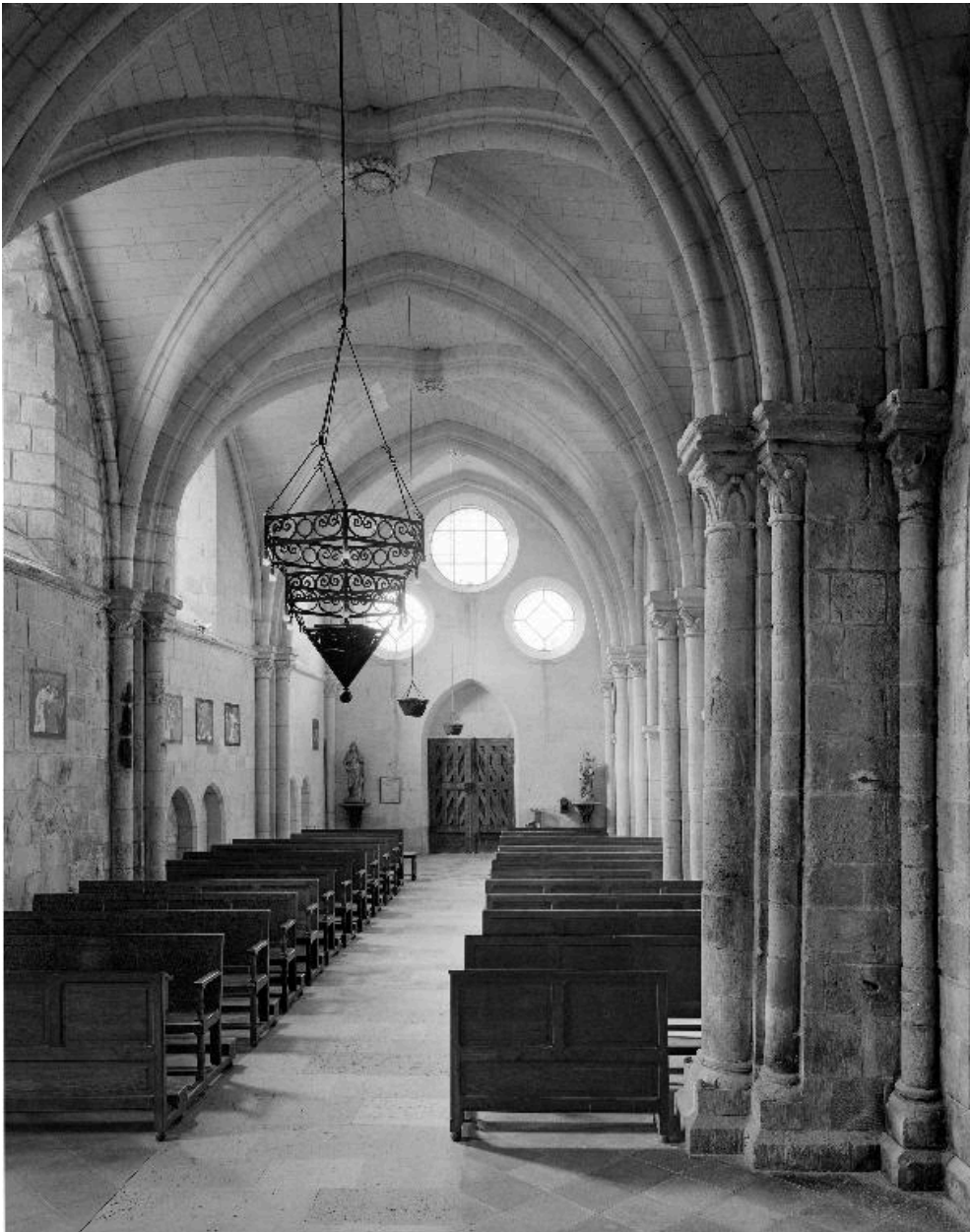
Vue intérieure de la nef, depuis le chœur vers l'entrée.
