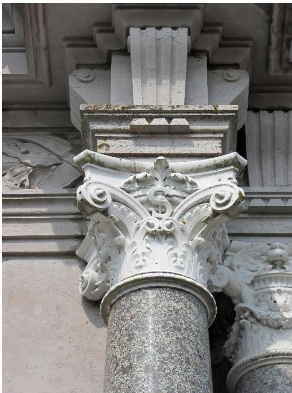
Détail d'un chapiteau corinthien orné de l'initiale S.
