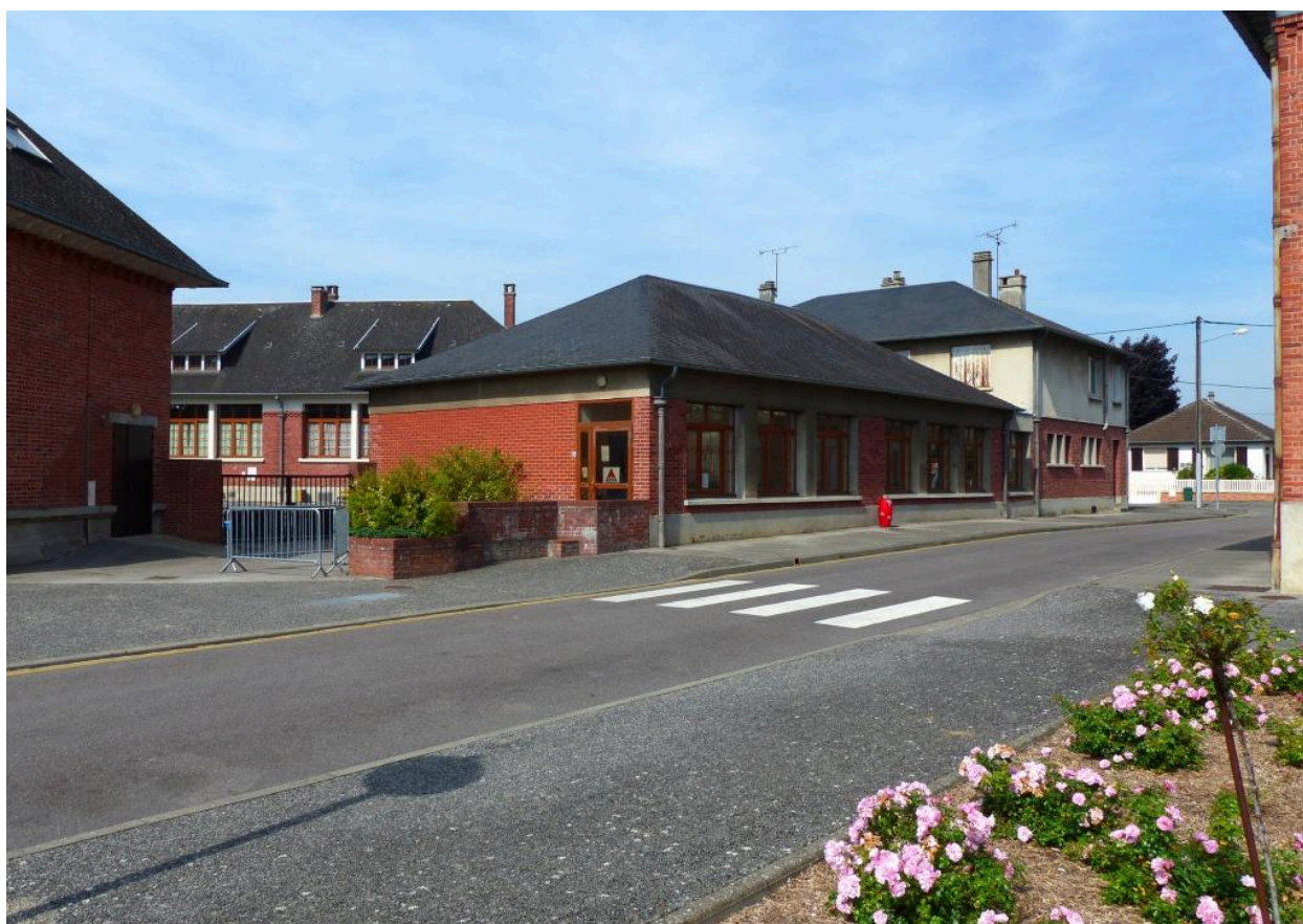
Vue des nouveaux bâtiments construits en 1960, à l'emplacement de l'ancien bassin.
