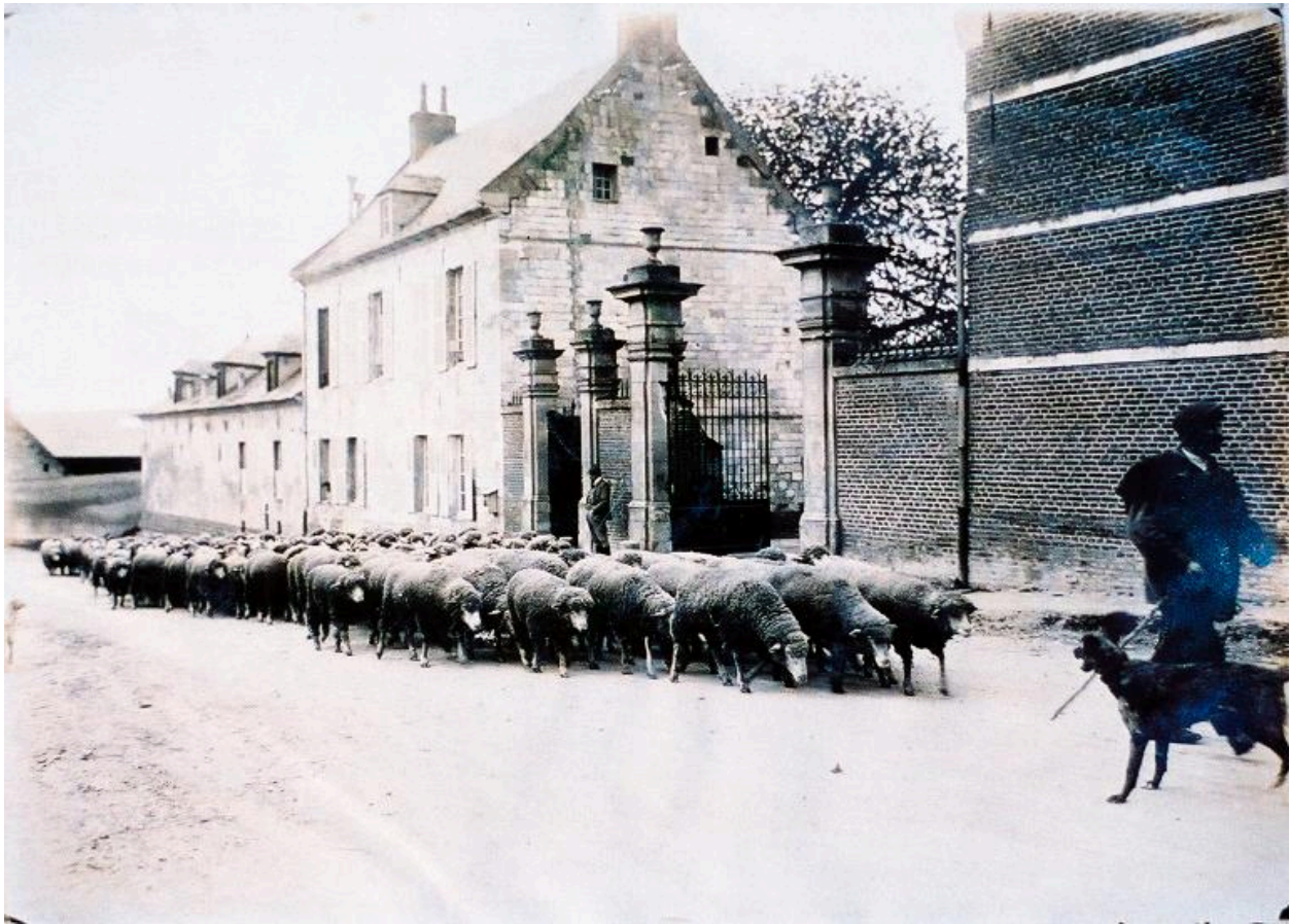
Bâtiments d'entrée, avant 1914 (AD Somme ; 10 R 501).
