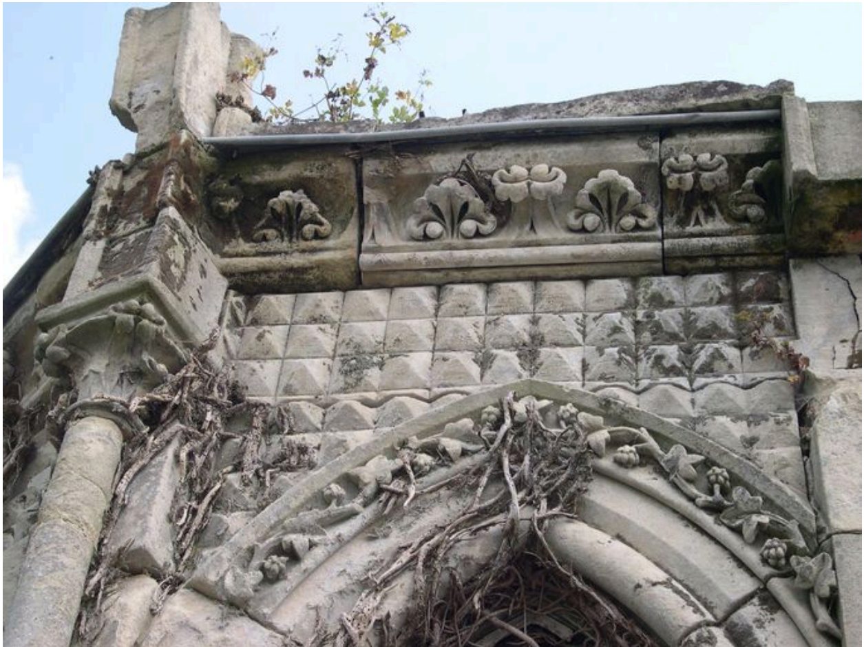
Vue de détail : partie supérieure d'une travée du mur sud.
