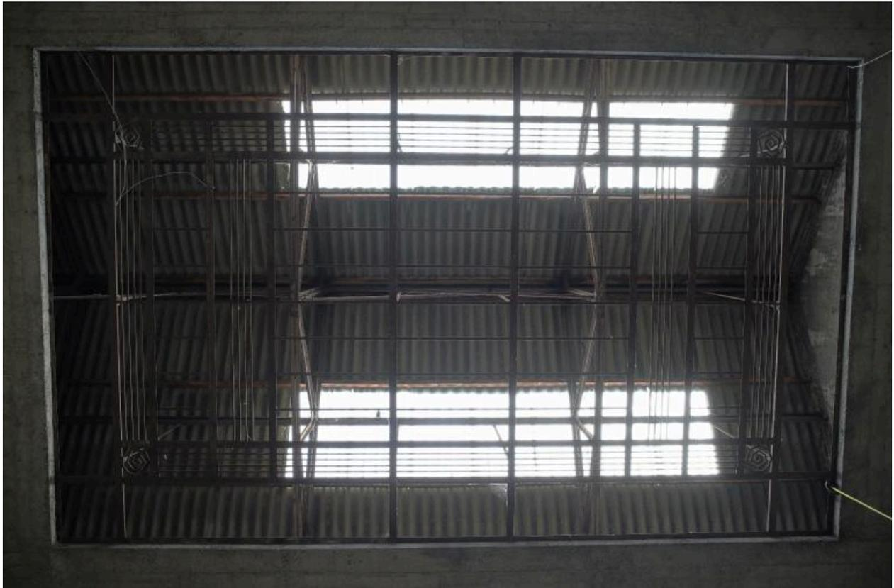
Charpente métallique et couverture en tôle ondulée avec double bande d'éclairage zénithal du troisième atrium.
