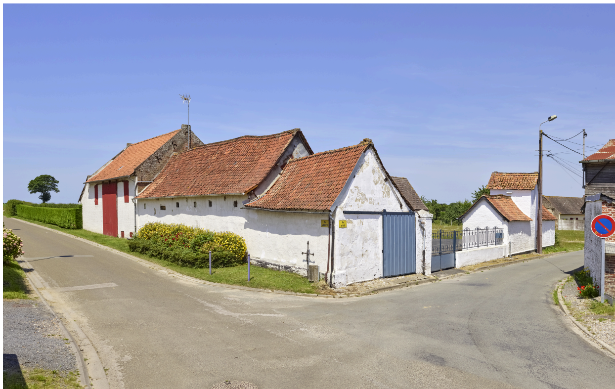
Vue d'ensemble de la ferme, depuis l'est.
