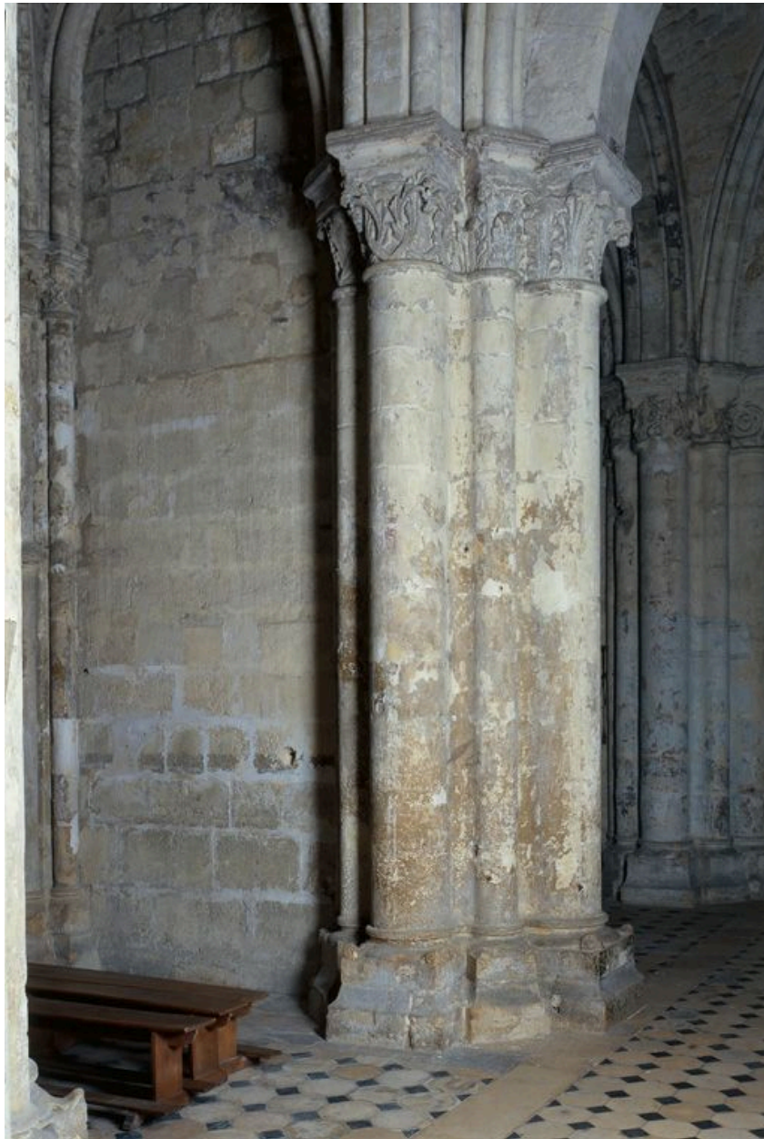
Vue intérieure du déambulatoire, pilier du côté nord.
