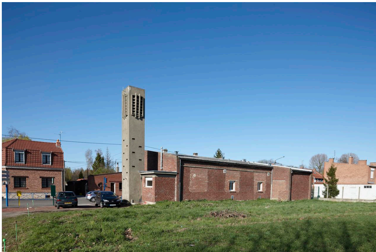
Vue de l'élévation antérieure.
