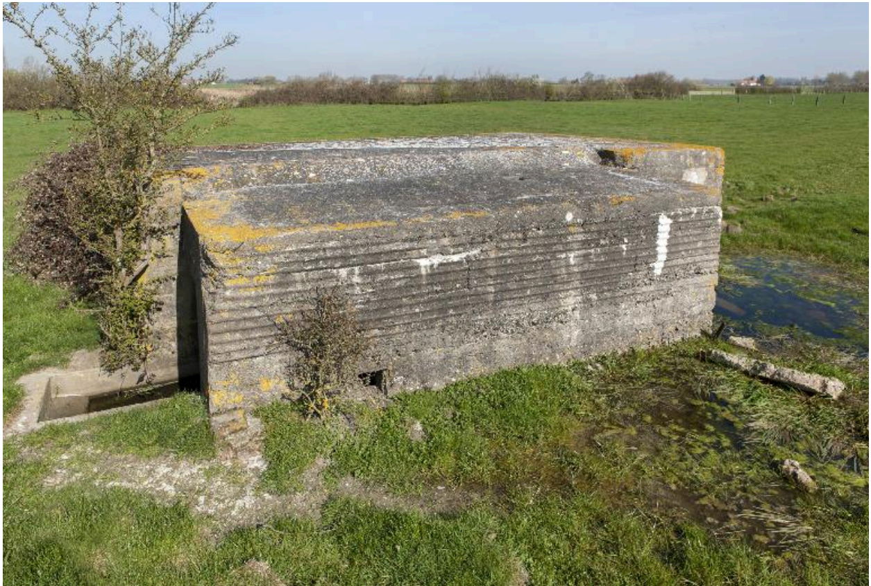
Vue en plongée montrant le couvrement et l'entrée ouest
