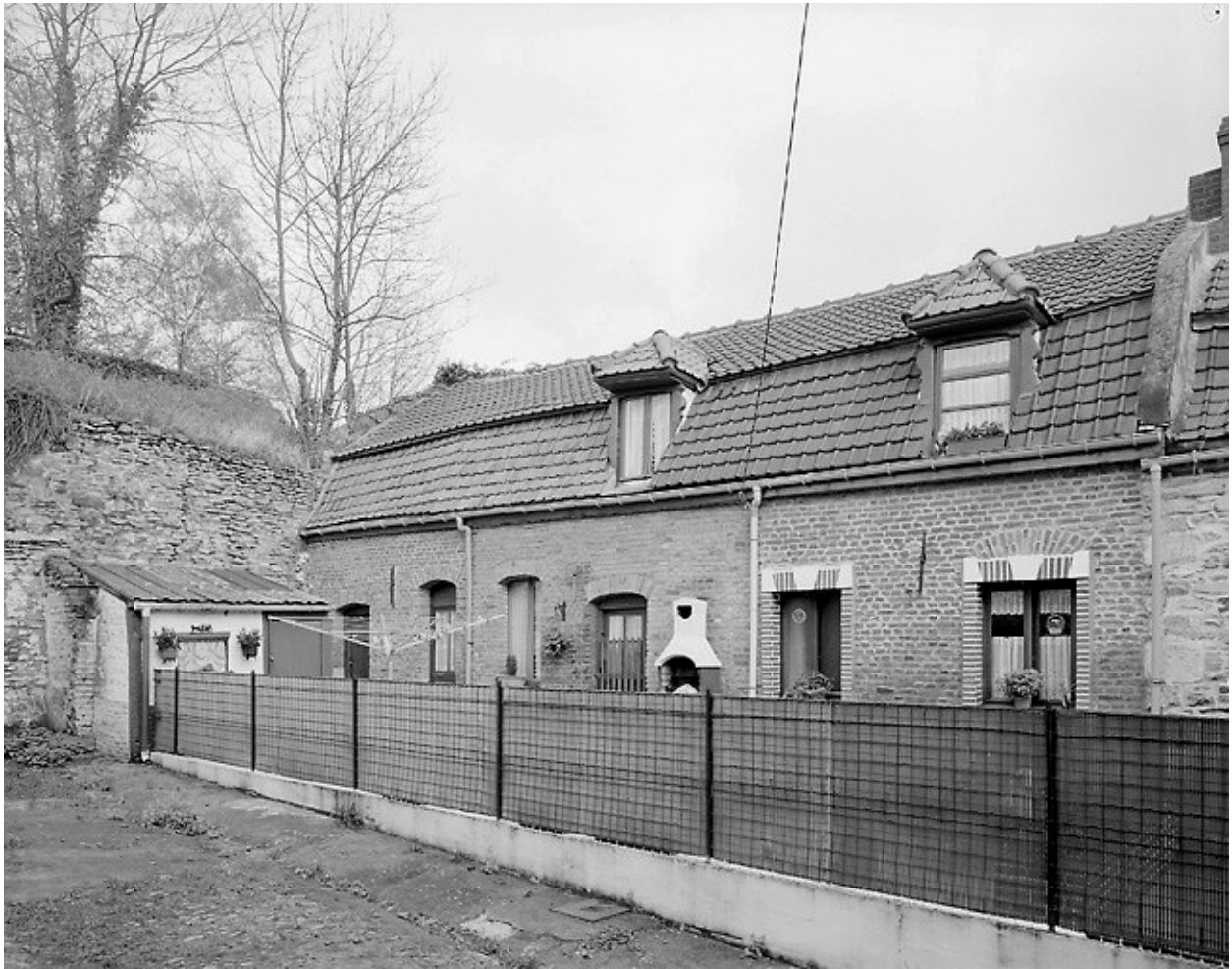
Courée, vue partielle : rang de maisons nord-est ; à gauche, le rempart médiéval (état en 2000).
