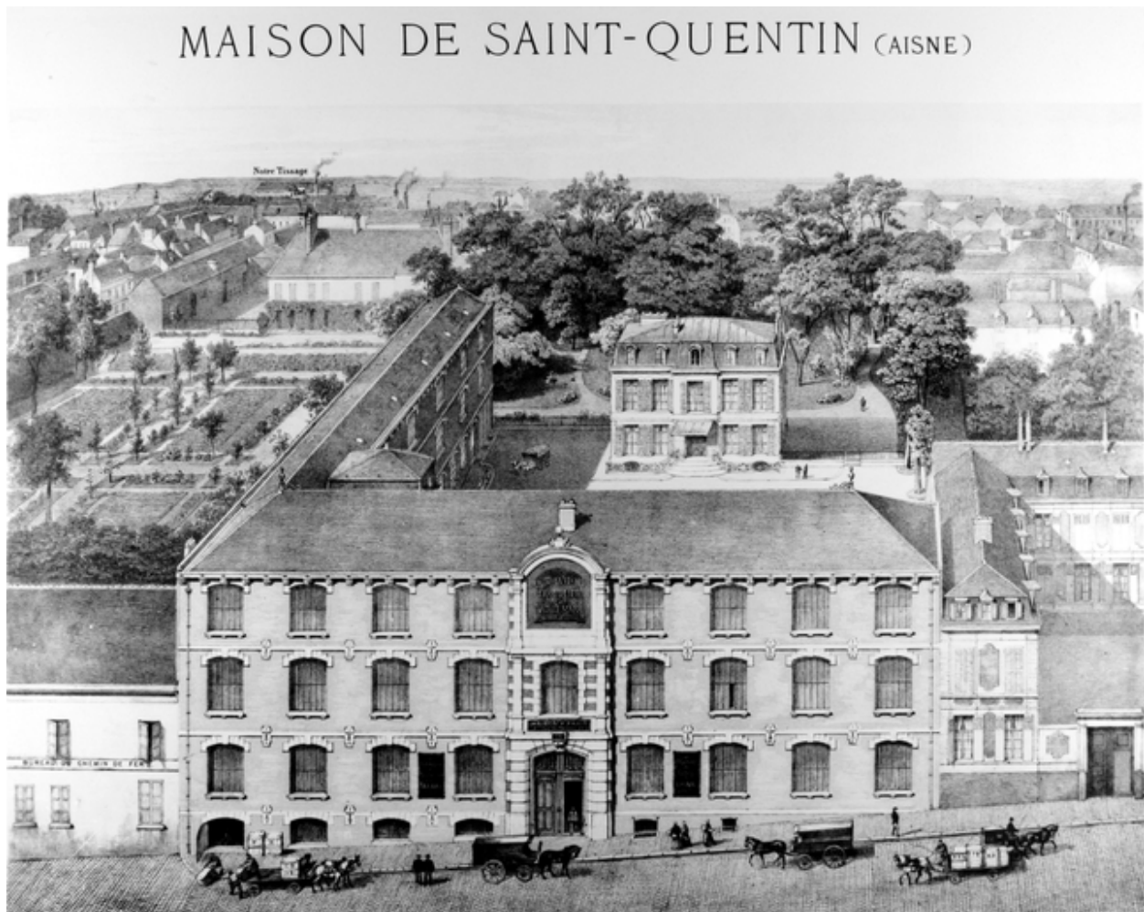
La maison de commerce David, Troullier et Adhémar avant 1900 (BM Saint-Quentin)
