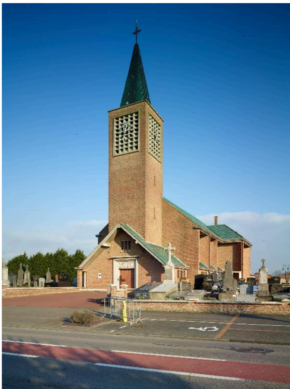
Elévation antérieure de trois quart droit
