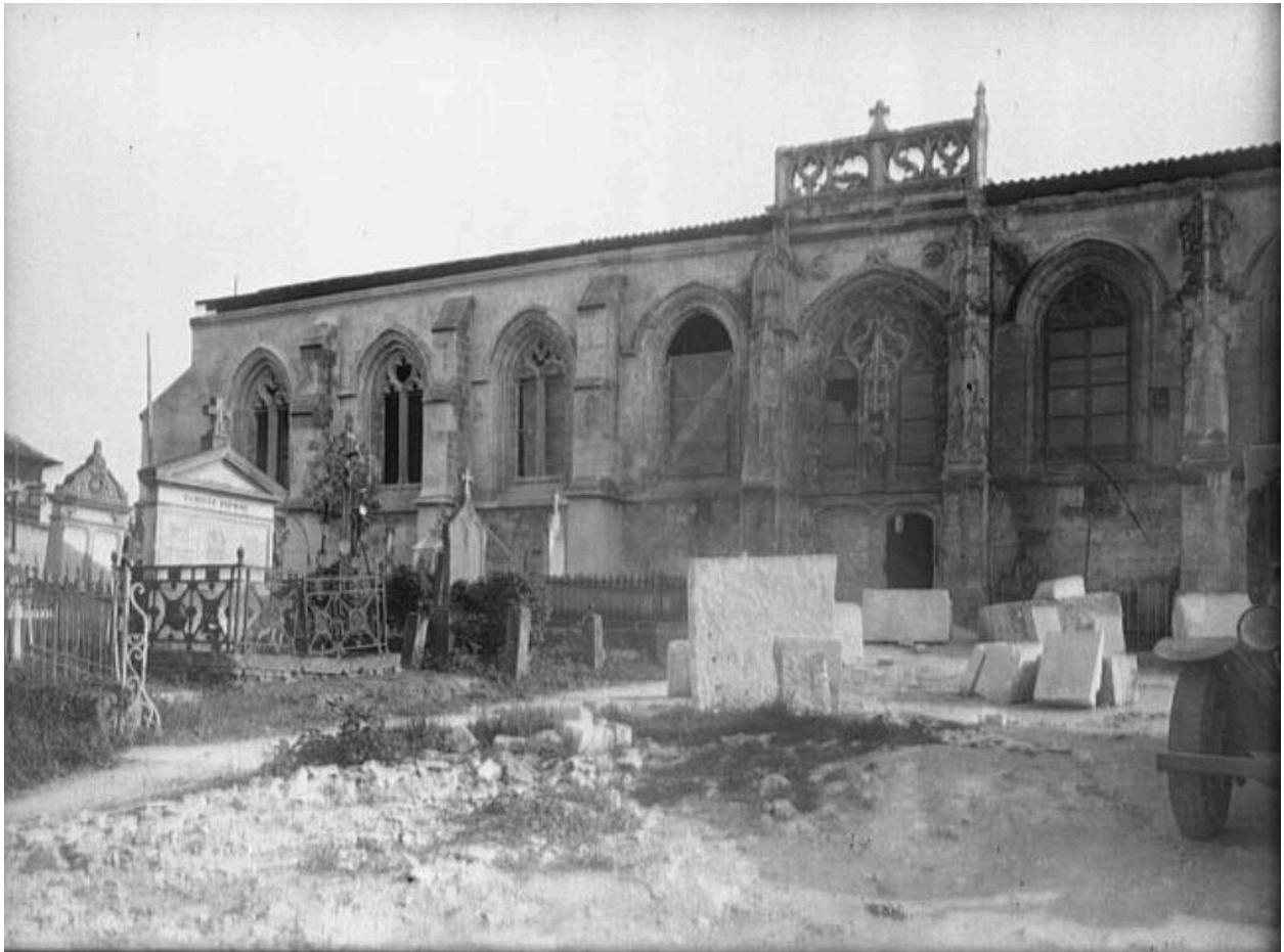
Chantier de restauration de l'église de Fontaine-sur-Somme, 1950 (Charenton-le-Pont, médiathèque de l'architecture et du patrimoine ; AP02L04153).
