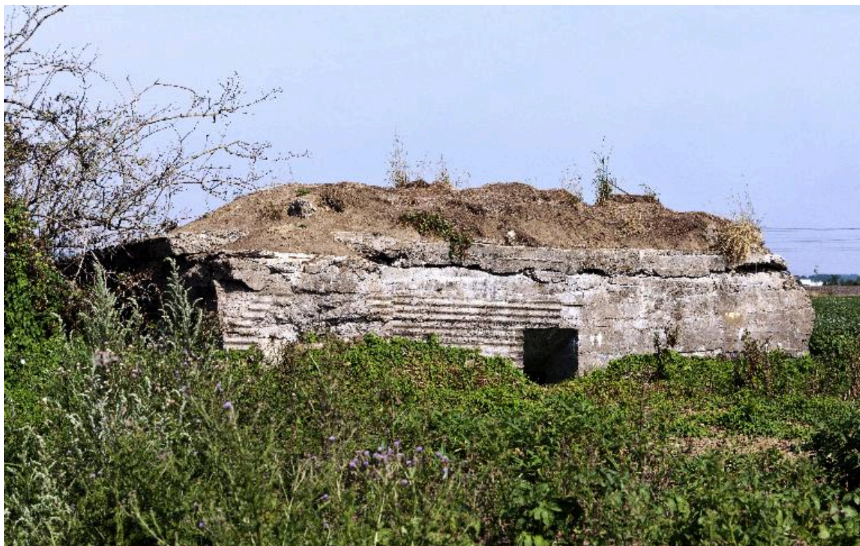
Vue de trois-quarts vers nord
