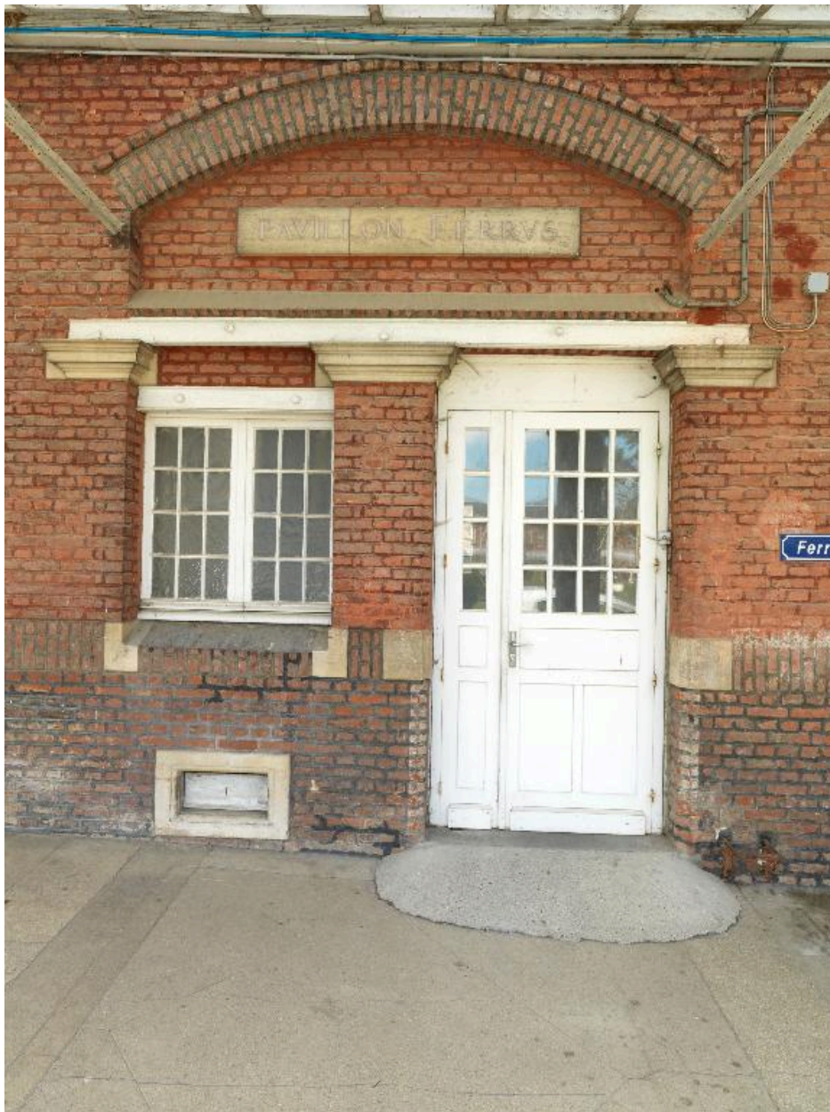
Ancien régime commun (quartier des femmes). Travée d'accès du pavillon Ferrus.
