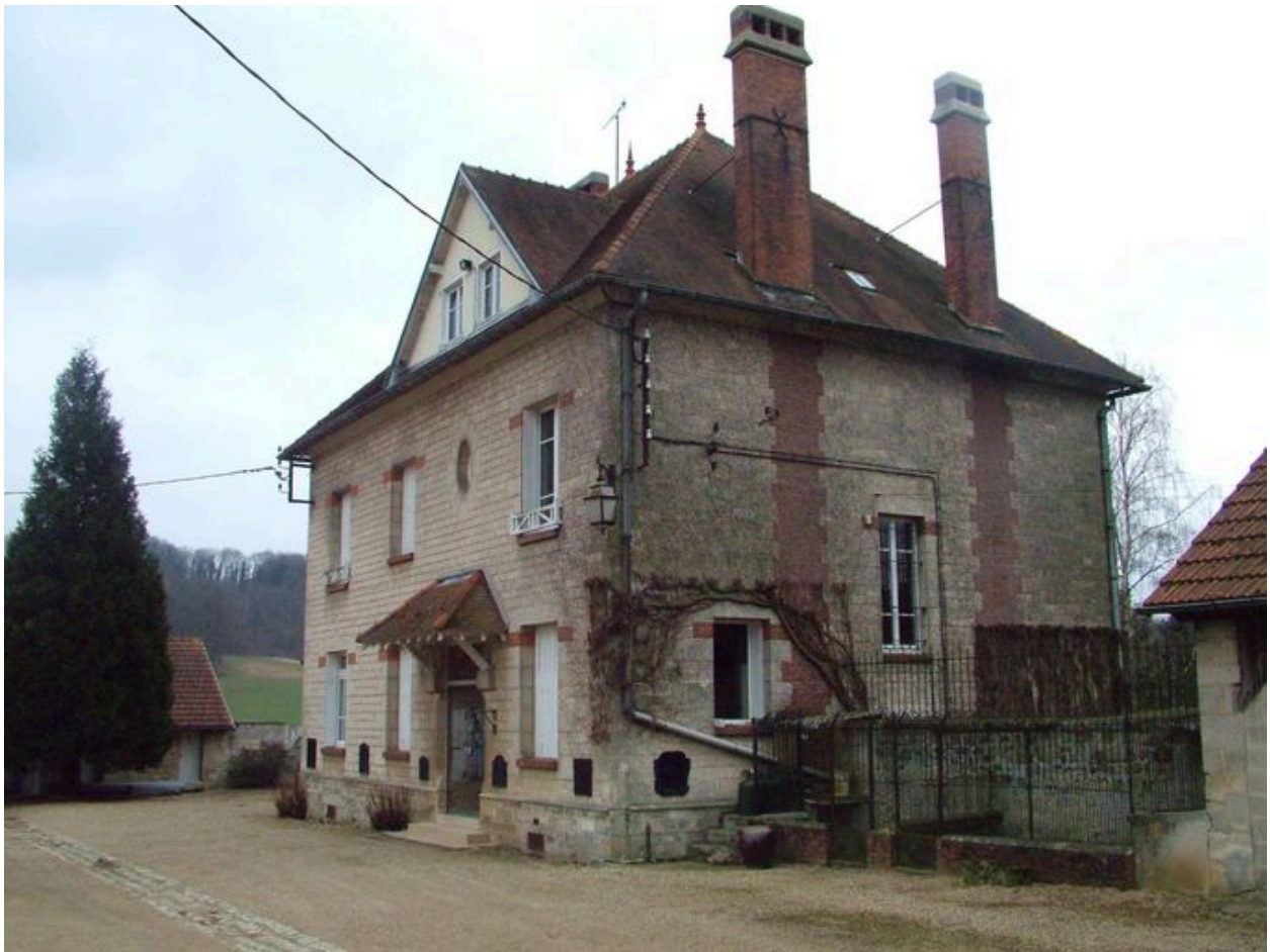
Vue générale du logis de la ferme.
