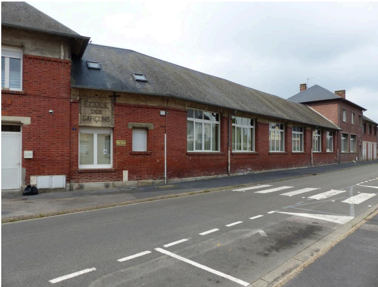
L'entrée de l'ancienne école de garçons et les salles de classe.
