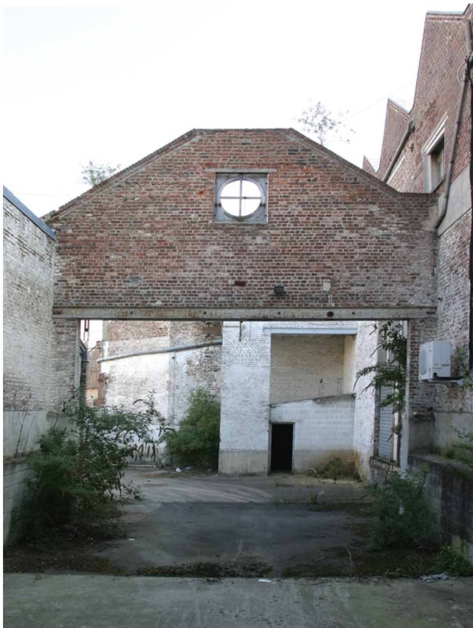
Pignon de l'ancienne salle des machines.
