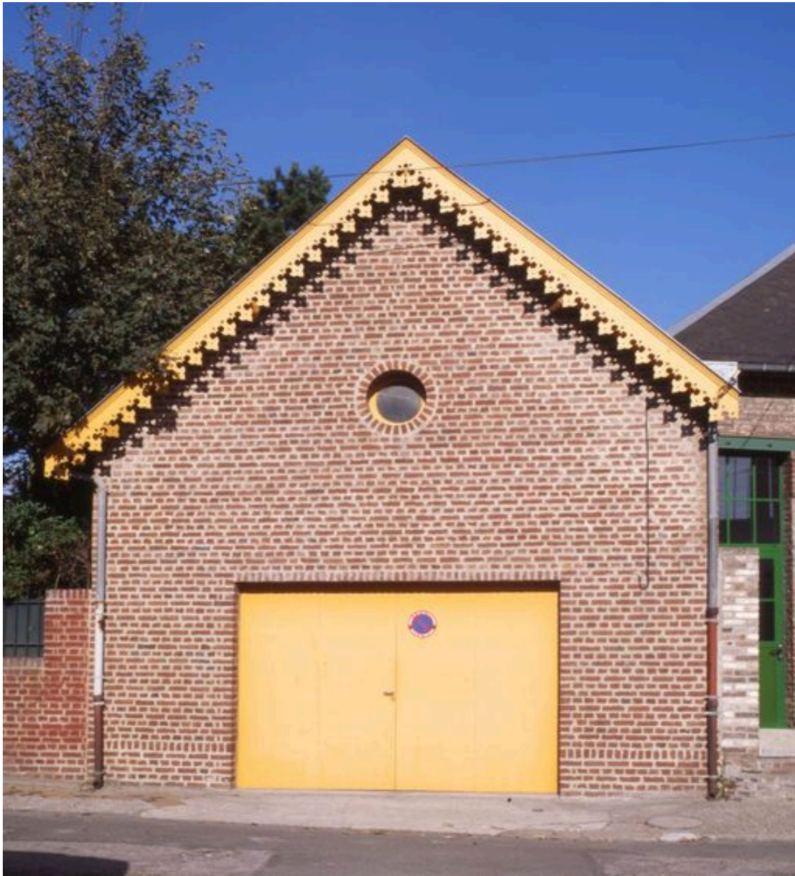
Le garage isolé.
