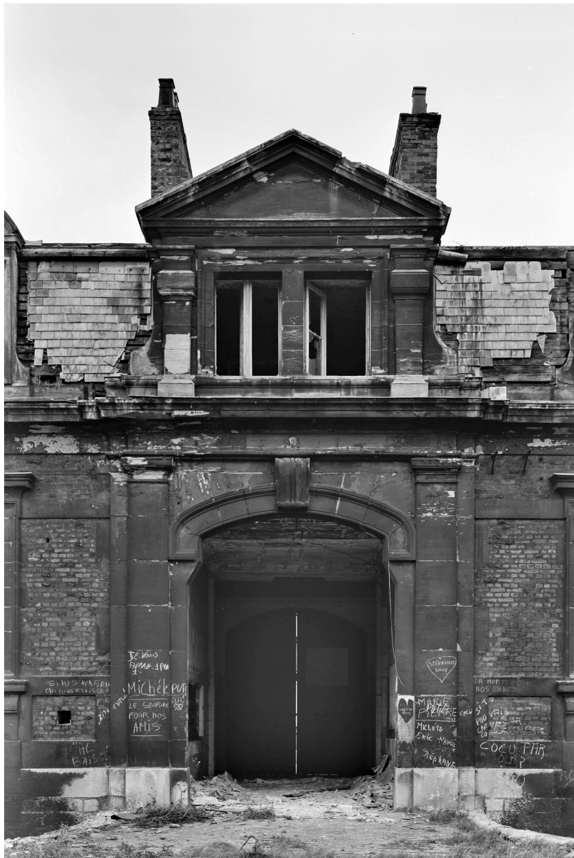
Bâtiment A, portail d'entrée, façade sur cour.
