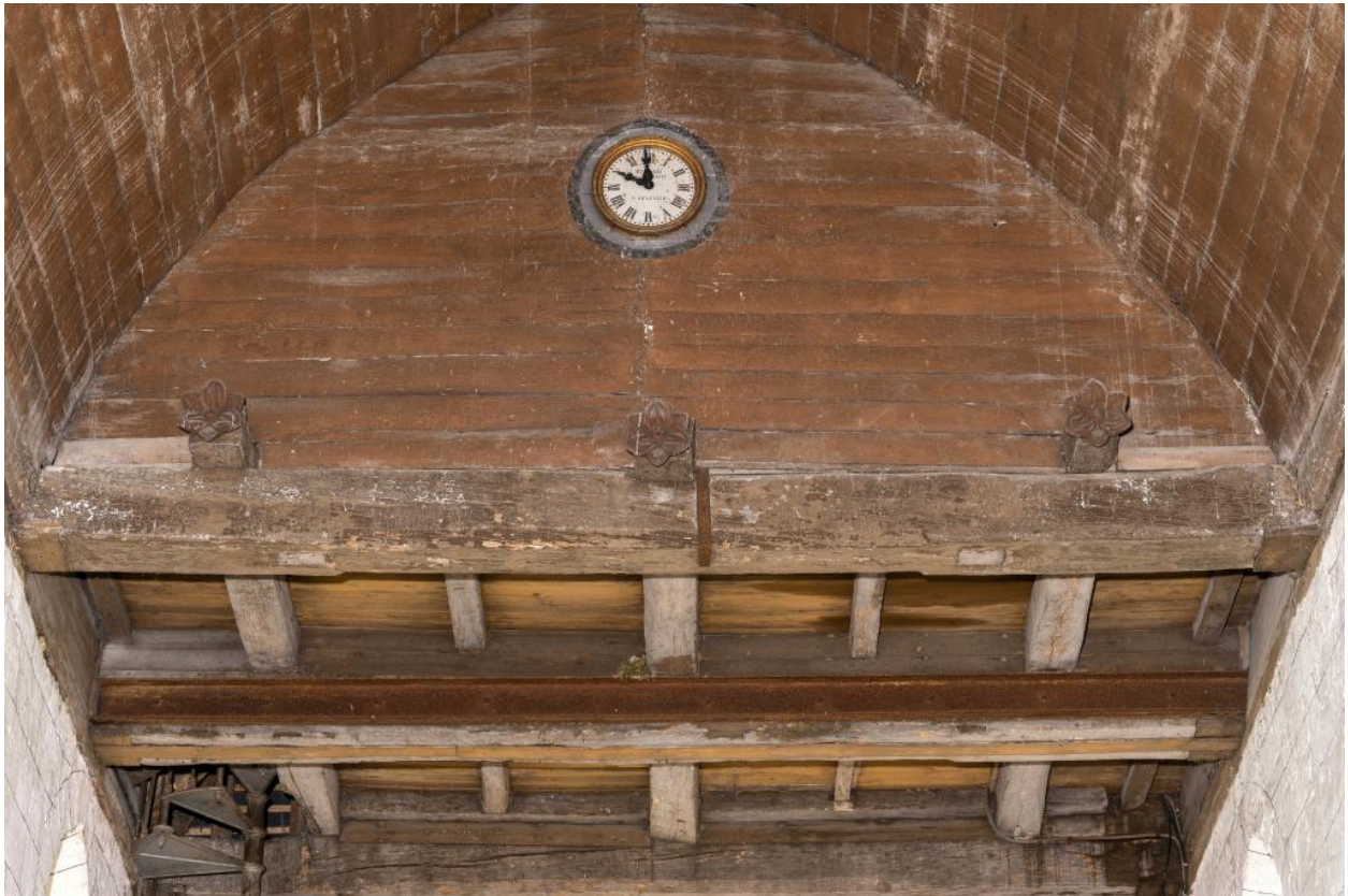
Vue du premier étage du clocher avec blochets sculptés.
