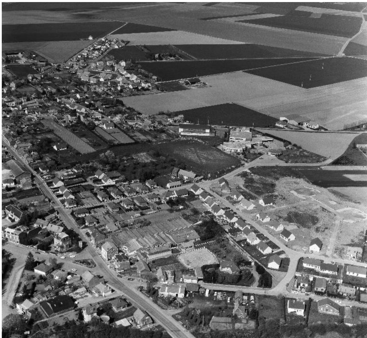
Vue aérienne, flanc sud-ouest.
